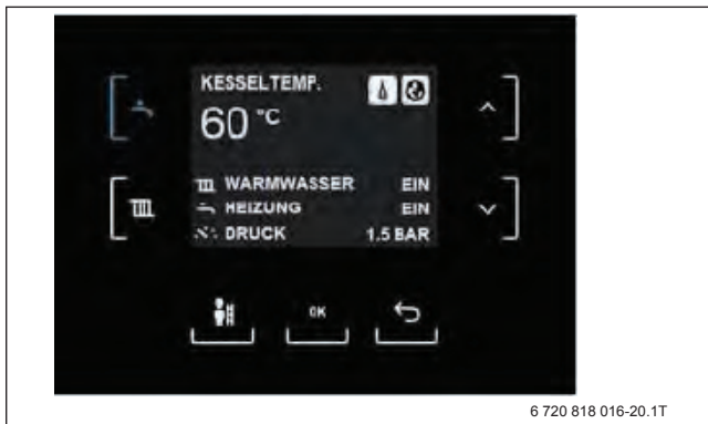
Bild 29 Basiscontroller Logamatic BC30 E
