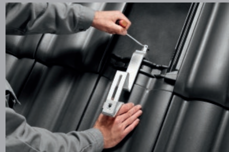
Verstellbarer Dachhaken für die Aufdachmontage.
